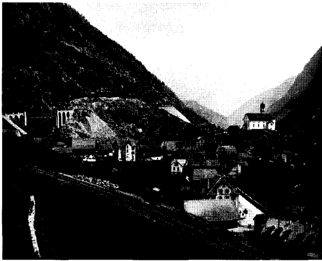
Bild 6: Mit der dreimaligen Umfahrung der Kirche von Wassen auf verschiedenen Niveaus schufen die Ingenieure der Gotthardbahn das Wahrzeichen der neuen alpenquerenden Eisenbahn durch die Schweiz. Das Bild zeigt die mittlere der drei Ebenen Richtung Norden, vor 1893. (Foto: Verkehrshaus der Schweiz Luzern)
