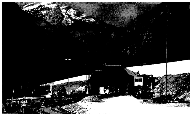
Bild 10: Tunnelportal des Gotthardbasistunnels auf der Südseite in Bodio. (Foto: AlpTransit Gotthard AG)
