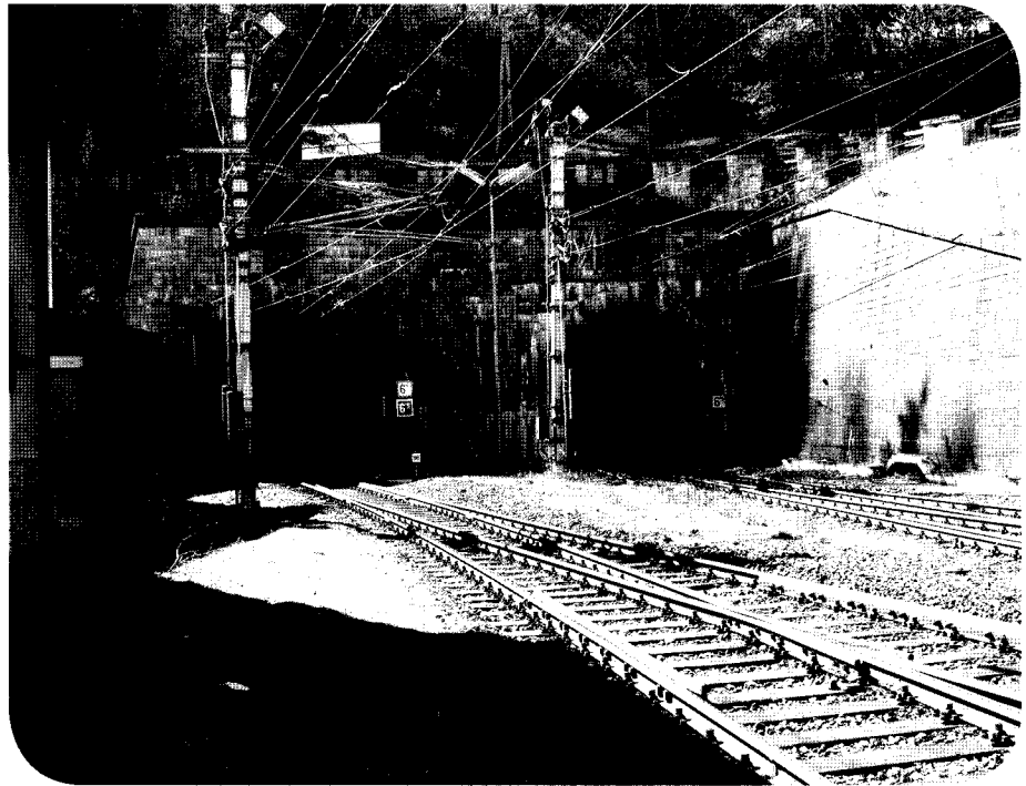
Bild 1: Das Nordportal des Semmering-Scheiteltunnels. 1952 wurde die zweite Röhre dem Verkehr übergeben. (Foto: Kilian T. Elsasser)
